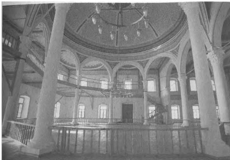
Центр Мевляны (внутренний вид) в г. Гелиболу.
